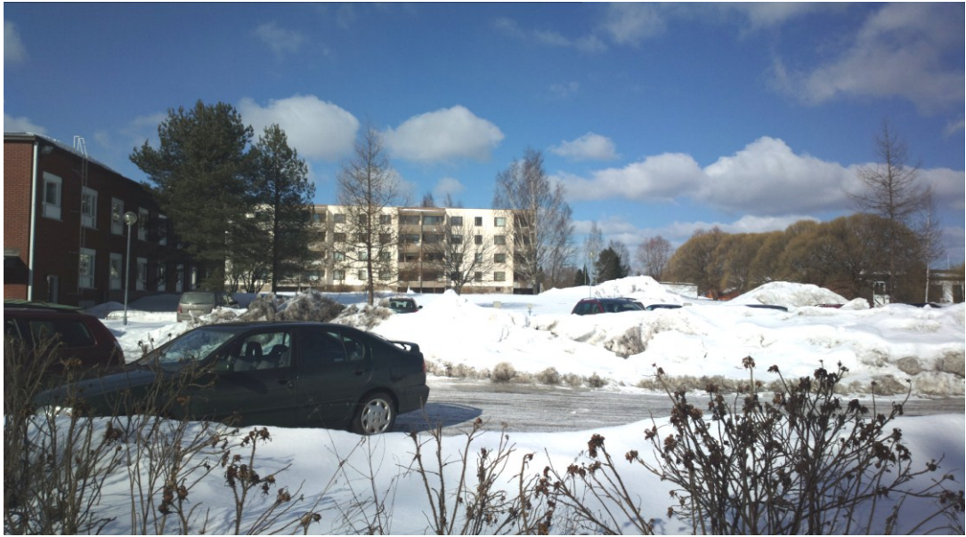
Kuva 7. Kortteli 210 Kotokartanon laajennus tontti n:o 5 etelästä kuvattuna.
